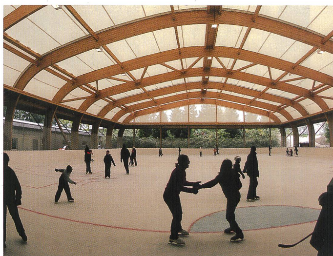
Das erneuerte und nun überdachte Aussenfeld der Eisbahn
