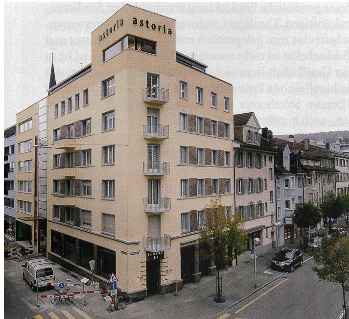
Im Rahmen des Projektes Wohn- und Gewerbepark Hübeli wurde von Marius Studer das Hotel Astoria erneuert und erweitert.
