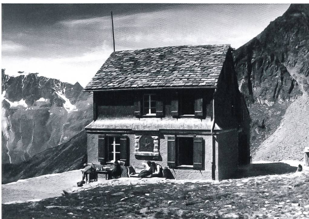
Die alte Weissmieshütte 1925
