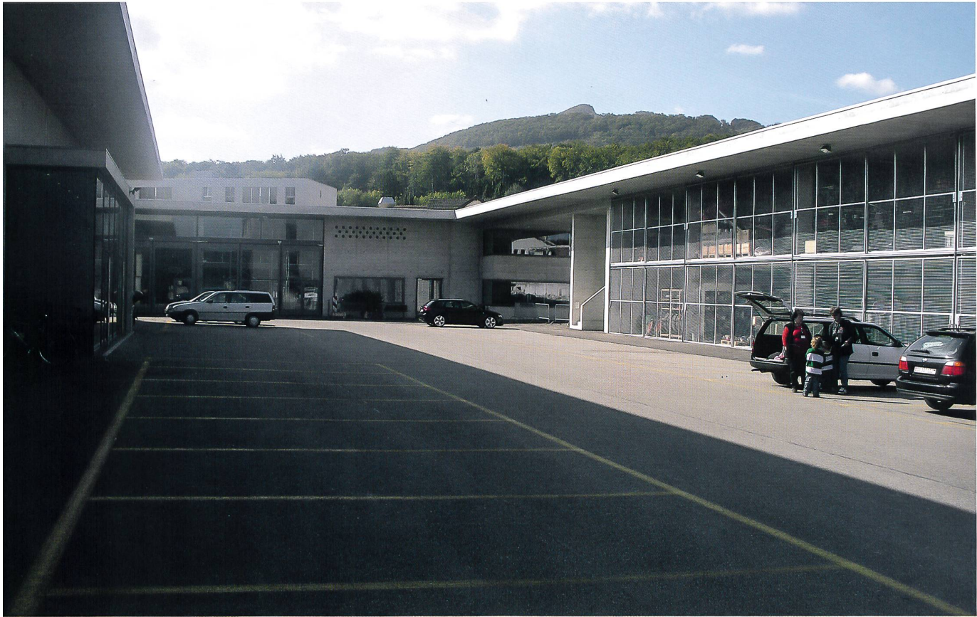
Neubau Werkhof unmittelbar neben dem Feuerwehrmagazin
