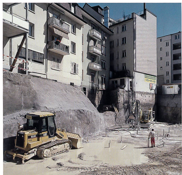
Sprengungen mitten in Olten – die Baugrube wird ausgehoben.
