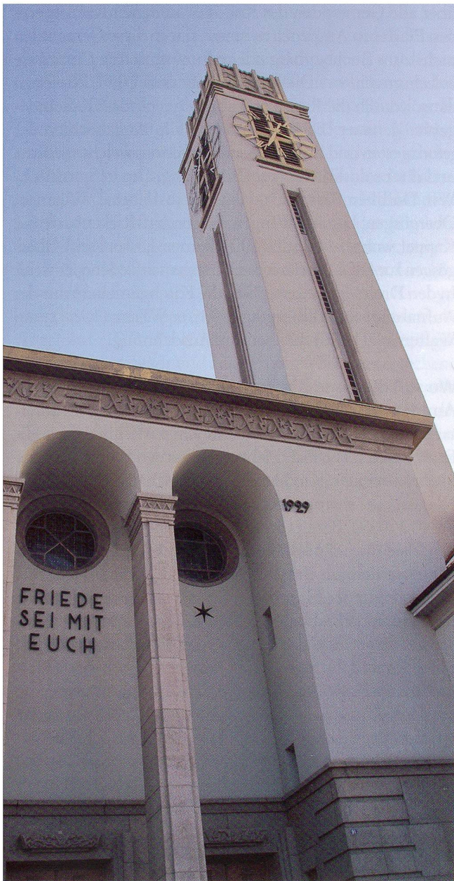
Die erste Kirche von 1859 wurde bald zu klein. Mit der Friedenskirche von 1928 entstand ein markantes Bauwerk.
