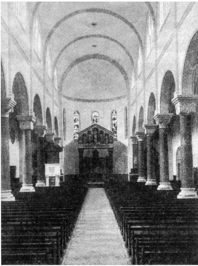
Das Extrablatt der «Oltner Nachrichten» am Einweihungstag vom 14. August 1910 ermöglicht einen Blick in das Kircheninnere, noch ohne die Freskomalereien von Fritz Kunz in der grossen Apsisrotunde und in der ursprünglichen Anordnung mit dem Baldachin über dem Hochaltar und der Kanzel mit dem Schalldeckel vor der ersten linken Säule
