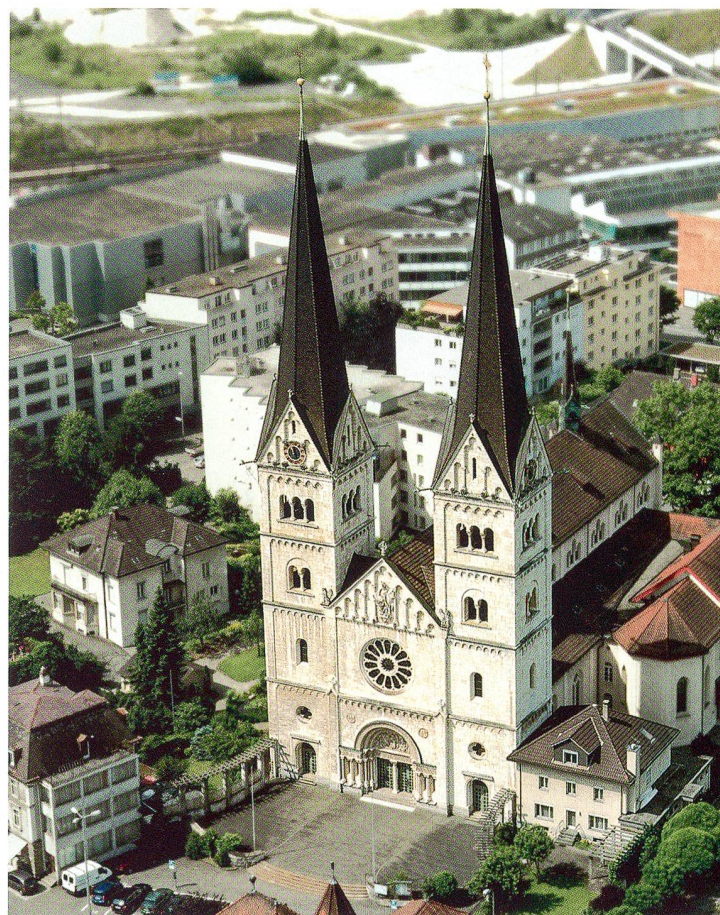
Flugaufnahme der St.-Martins-Kirche mit Pfarreiheim (altes Pfarrhaus) und Saalbau (ehemalige «Notkirche») rechts, mit Pfarreigarten, Pfarrhaus sowie Alters- und Pflegeheim St. Martin links, im Hintergrund die Seniorenresidenz Bornblick
