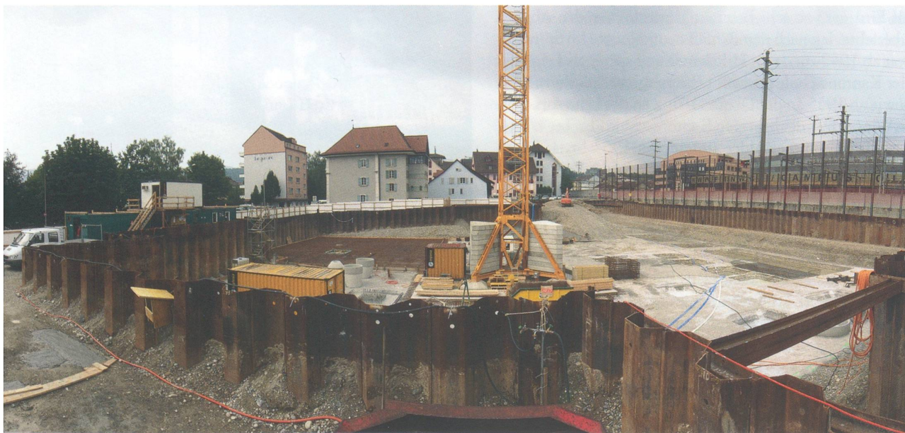
Die Masse von «Energy», dem Bauvorhaben auf dem Belserareal, sind beeindruckend: grösste Länge: 96 Meter, grösste Breite: 56 Meter, grösste Höhe: 23 Meter.
