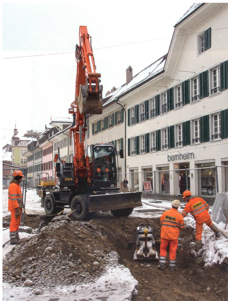
Während der Bauphase herrschten zeitweise winterliche Verhältnisse. Doch selbst der Schnee konnte die Bauleute nicht vom Arbeiten abhalten.
