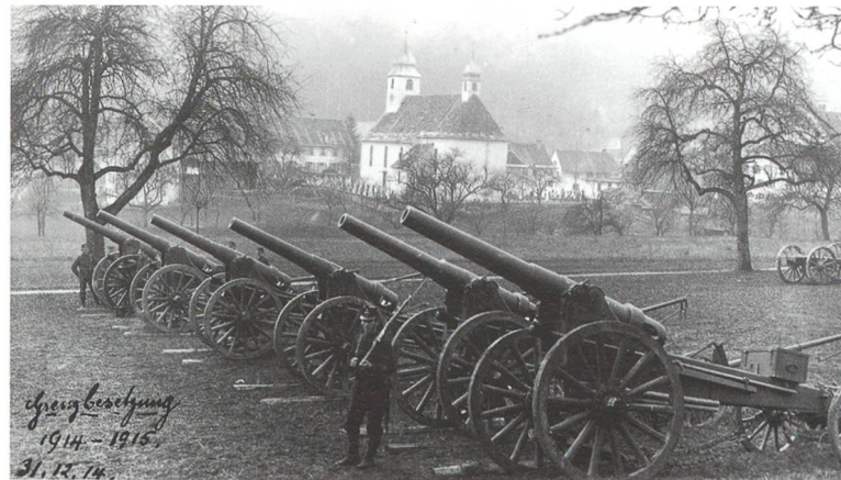
Eine Batterie 12cm Ringrohrkanonen wartet in Trimbach auf die Verschiebung nach der «Fortifikation Hauenstein».
