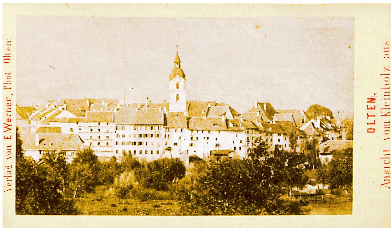
Emil Werner: Leporello Olten 1874: Blick von der Husmatt gegen die Altstadt. Von den drei wieder hergestellten Häusern (mit regelmässiger Fenstereinteilung) ist der Spittel noch eingerüstet.
