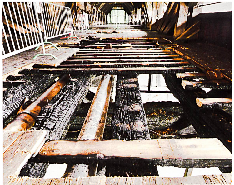
Die Schäden in der Tragkonstruktion der Alten Brücke sind enorm.
