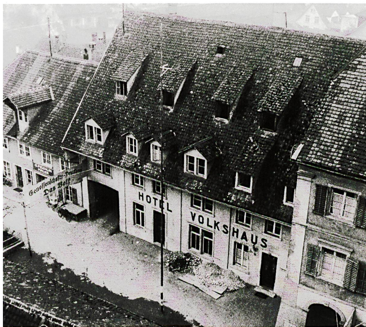
Das «Volkshaus» (vormals «Bierhalle zur Krone» der Brauerei Hemptele) 1938 vor dem Umbau zum «Glockenhof»
