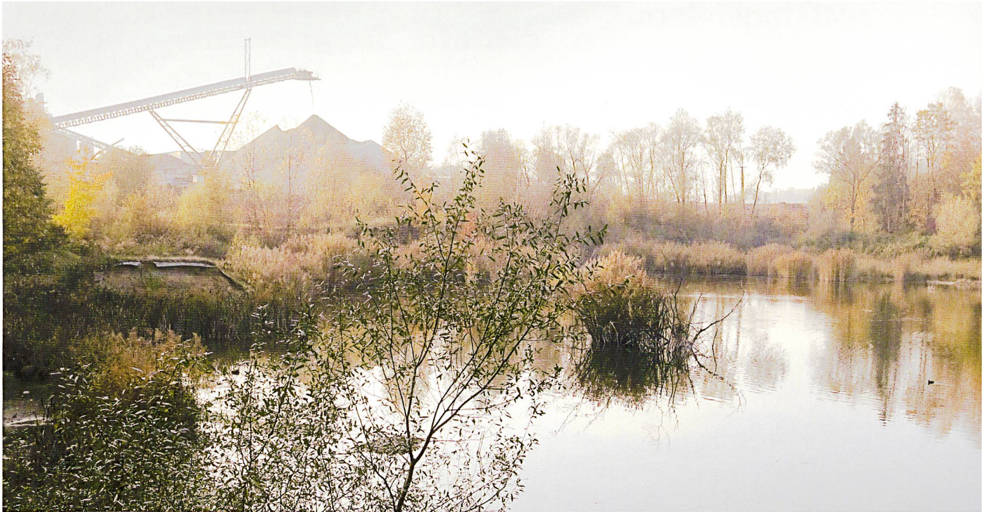
Werkplatz Kieswerk Gunzgen
