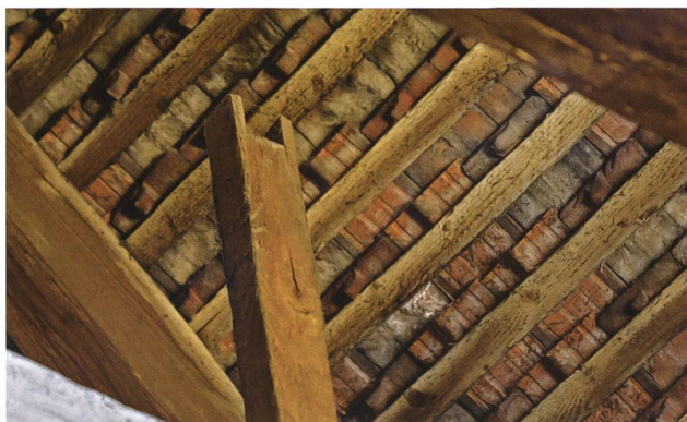
Detail eines Ständers der ehemaligen Übertragungsleitung auf dem Estrich der Stadtkirche
