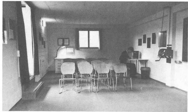
Blick in den Vorraum, der unter anderem für Dia-Vorführungen und Kurzvorträge eingerichtet ist. Mit dem rechts erkennbaren Schneckengetriebe lässt sich das etwa vier Tonnen schwere Giebeldach leicht von Hand öffnen.
