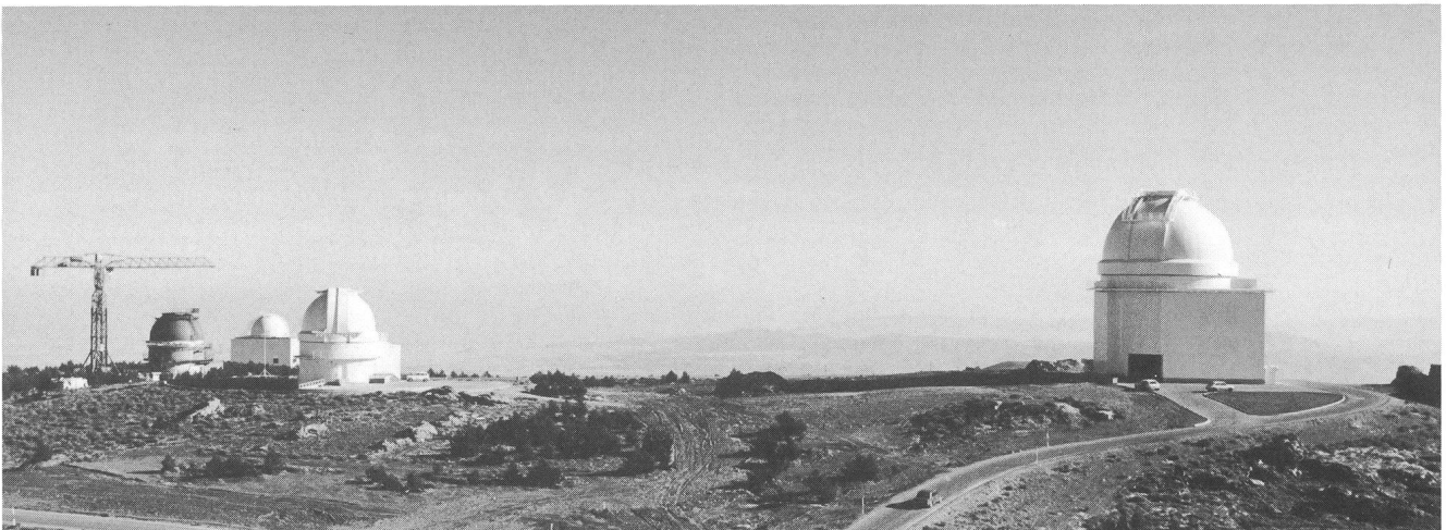
Abb. 1: Auf dem Calar-Alto im September 1979. Blick von der Baustelle für das 3,5 m-Teleskop auf die übrigen Kuppelbauten. Von links nach rechts die Gebäude für die Schmidt-Kamera (noch im Bau), das spanische 1,5 m-Teleskop, das 1,2 m- und das 2,2 m-Fernrohr.
