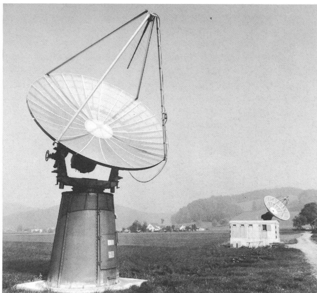
Abb. 1: Die Antennenanlage und Meßstation bei Gränichen wurde im Herbst 1979 in Betrieb genommen.
