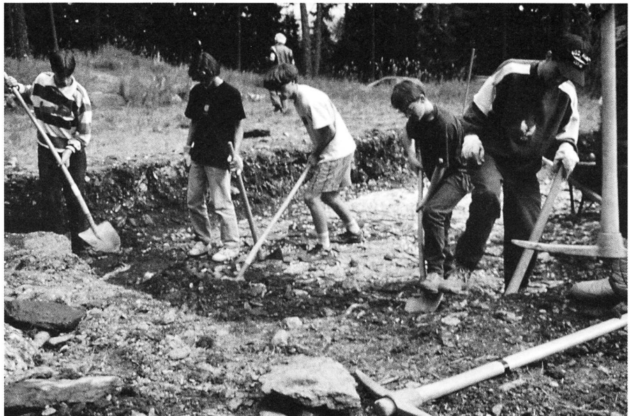
Fig. 2: les fouilles du futur observatoire sont réalisées par les élèves.
