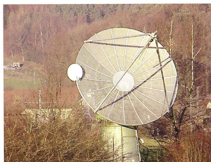
Fig. 1: 80cm Satellitenspiegel, montiert an einem 5m-Spiegel im Radioobservatorium in Bleien AG. Das Observatorium mit der Empfangsanlage ist etwa 50m östlich von der Antenne (im Bild rechts des Turmes).
