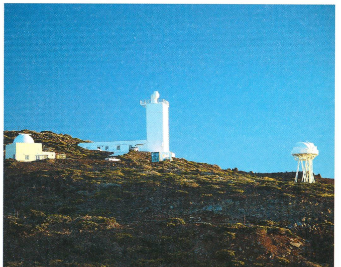
9. Les installations solaires suédoises et hollandaises. La structure du télescope hollandais, à droite, a des propriétés semblables à la monture Serrurier qui la rend moins sensible aux déformations induites par le vent.
