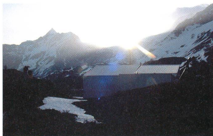
Fig. 1: AGO-Sternwarte auf dem Simplon-Pass: Sonnenaufgang über dem Kaltwassergletscher.
