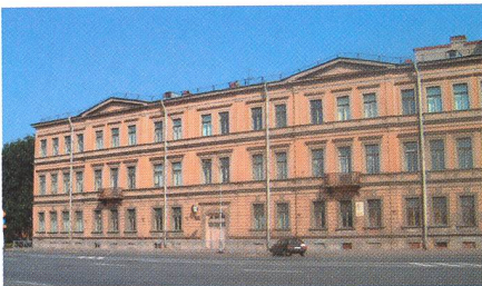
Fig. 7: Das Haus LEONHARD EULERS am Leutnant-Smidt-Kai 15, das er zwischen 1766 und 1783 bewohnte. Das dritte Stockwerk wurde erst im 19. Jahrhundert gebaut. (Bild: A. VERDUN)
