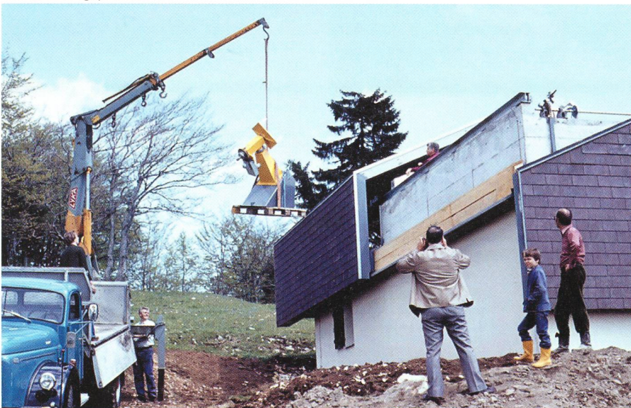
15.5.1976: Ein Autokran hievt die Montierung des 30-cm-Newton auf die Beobachtungsplattform.
