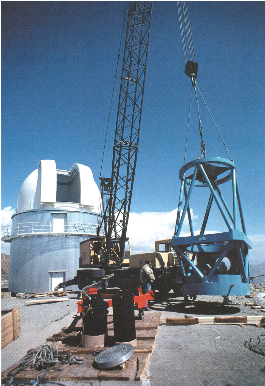
Fig. 15. Assemblage du télescope danois de 1m50 (février 1976).
