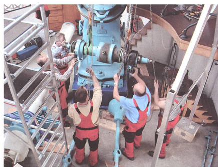
Fig. 11: Obwohl dem ganzen Fernrohr auch nach hundert Jahren Betriebszeit ein guter Zustand attestiert werden kann, hat der Zahn der Zeit dennoch seine Spuren hinterlassen.
