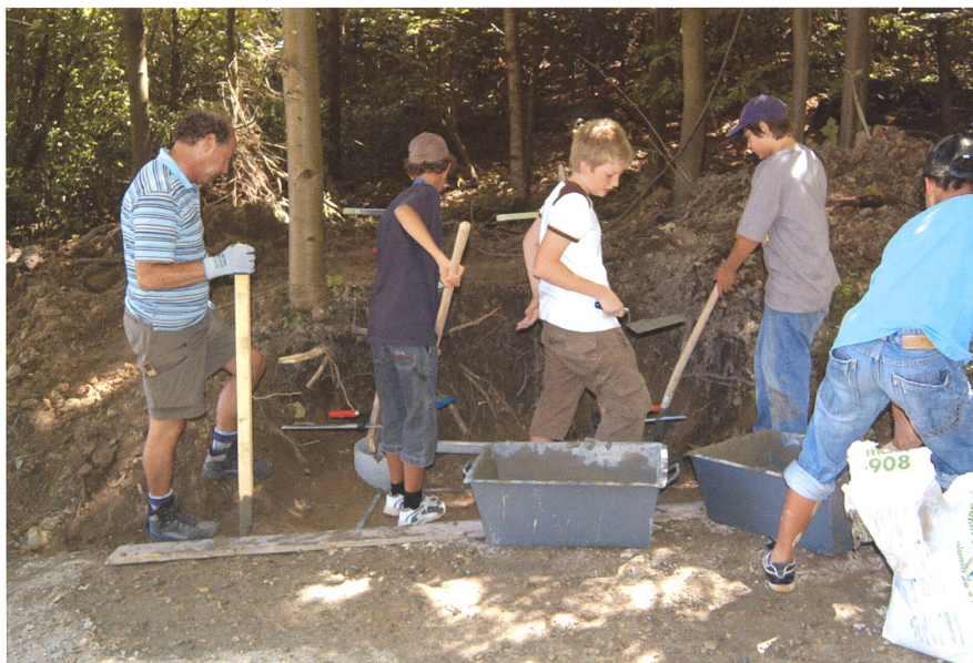
Geschwitzt wurde nicht nur an einem Tag. Hier schaufeln Schüler aus Regensdorf die Grube für das Fundament einer Schautafel. (Foto: Kiwanisclub Regensberg-Dielsdorf)
