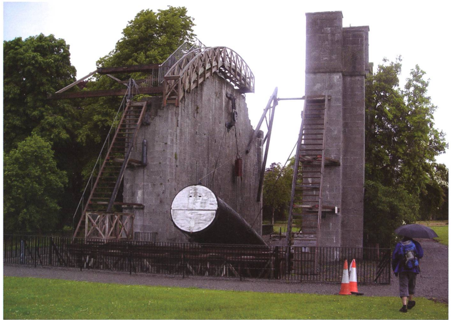
Südansicht des 18 Meter langen Teleskops mit Beobachtungsplattformen links oben am Mauerwerk. Bei Regen kann leider nicht beobachtet werden. (Foto: Christian Monstein)
