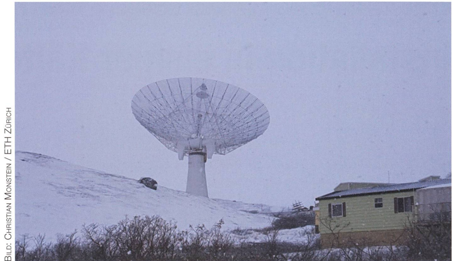
Abbildung 3: Die 32-Meter-Parabolspiegel mit der Radarstation (rechts). Horrend starke Radio-Signale mit 500 Mega Watt bei 1260 MHz werden in die Ionosphäre gestrahlt und die Echos gemessen und studiert. Nachts leuchtet ein grüner Laser weit in den Himmel. Der grosse Radar-Spiegel, der grüne Laser und die sich bewegenden Polarlichter hinterlassen einen tiefen, unvergesslichen Eindruck.
