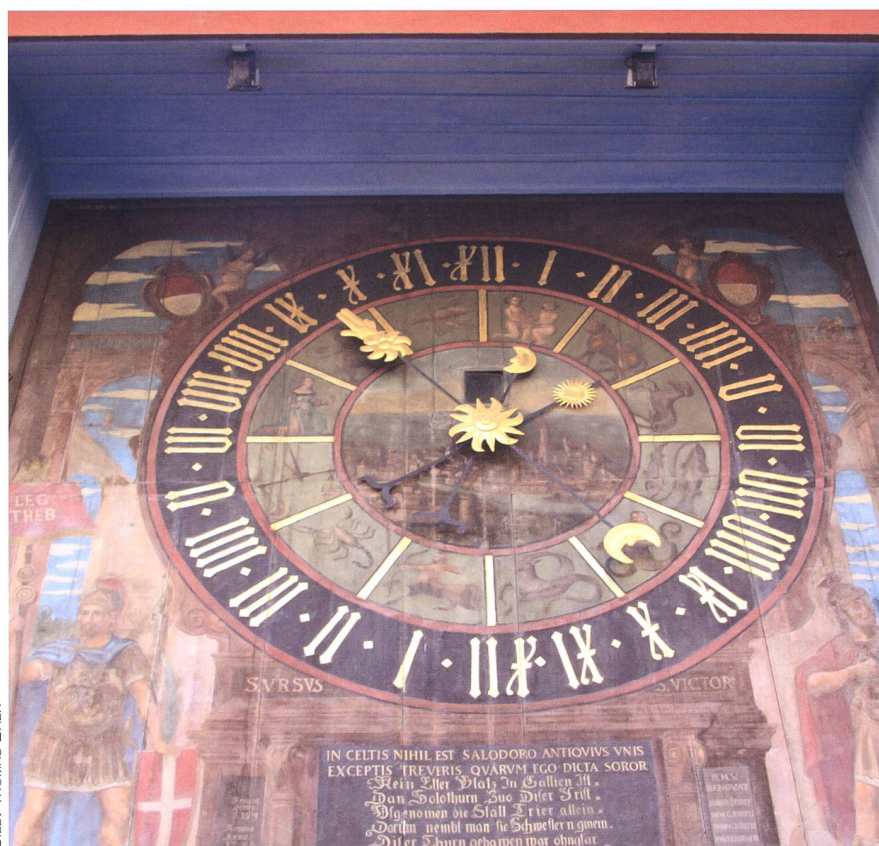
Abbildung 1: Die astronomische Uhr am Zeitglockenturm in Solothurn stammt aus dem Jahr 1545. Begonnen wurde das Werk durch den Winterthurer Uhrmacher LAURENTIUS LIECHTI, fertiggestellt durch JOACHIM HABRECHT. Das grosse astronomische Zifferblatt kündigt Tag, Monat sowie Mondstellung und Jahreslauf an.
