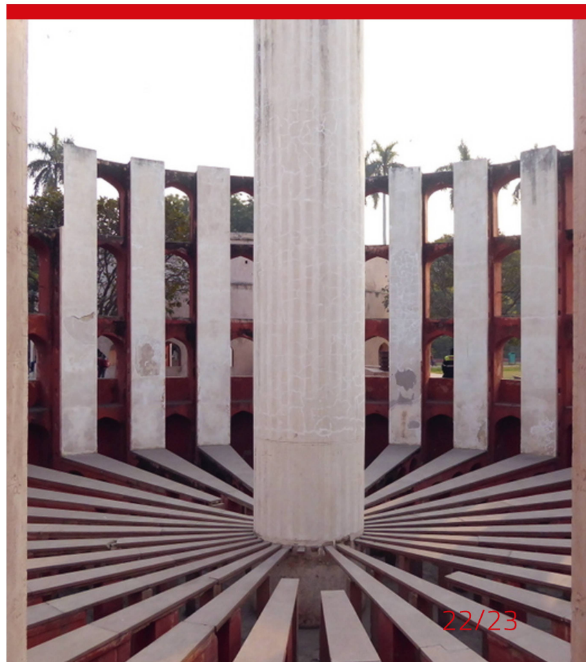
Abbildung 4: Das Innere eines der zwei Rama Yantras. Die Säule in der Bildmitte ist der Gnomon. Die geweissten Flächen waren mit Skalen versehen. Die Position eines Objekts wurde durch Anvisierung des Objekts, welches sich an der Oberkante des Gnomons befinden musste, bestimmt.
