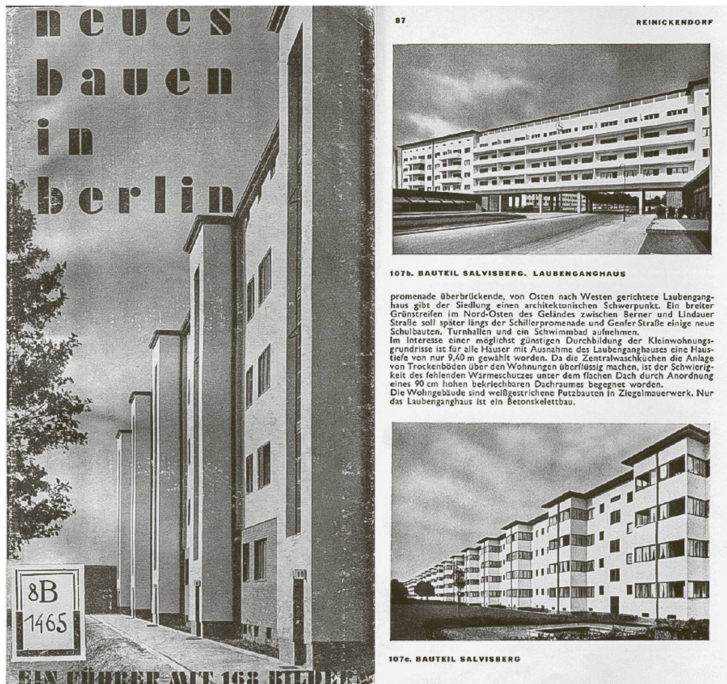
Abb. 1 Ansichten der Siedlung Schillerpromenade (1929/1930) in Berlin-Reinickendorf von O.R. Salvisberg, in: Heinz Johannes, Neues Bauen in Berlin. Ein Führer mit 168 Bildern , Berlin: Deutscher Kunstverlag, 1931 (Einband und S. 87)
