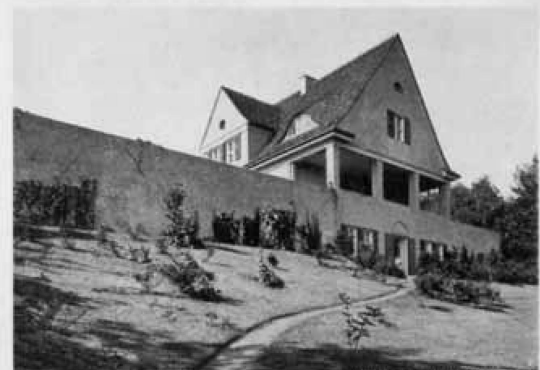
ARCH. LUDWIG RIEHL, POTSDAMBABELSBERG LANDHAUS DR. RIEHL IN POTSDAMBABELSBERG (LAGEPLAN UND GRUNDRISS: SEITE 50.)
