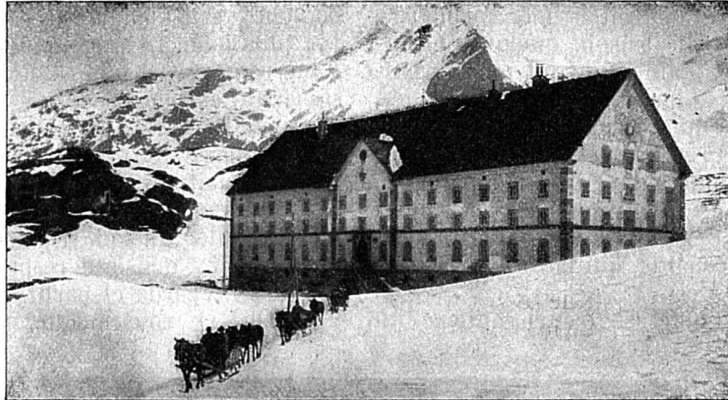
L'hospice du Simplon entre Brigue et Domo-d'Ossola, construit par ordre de Napoléon 1 er
