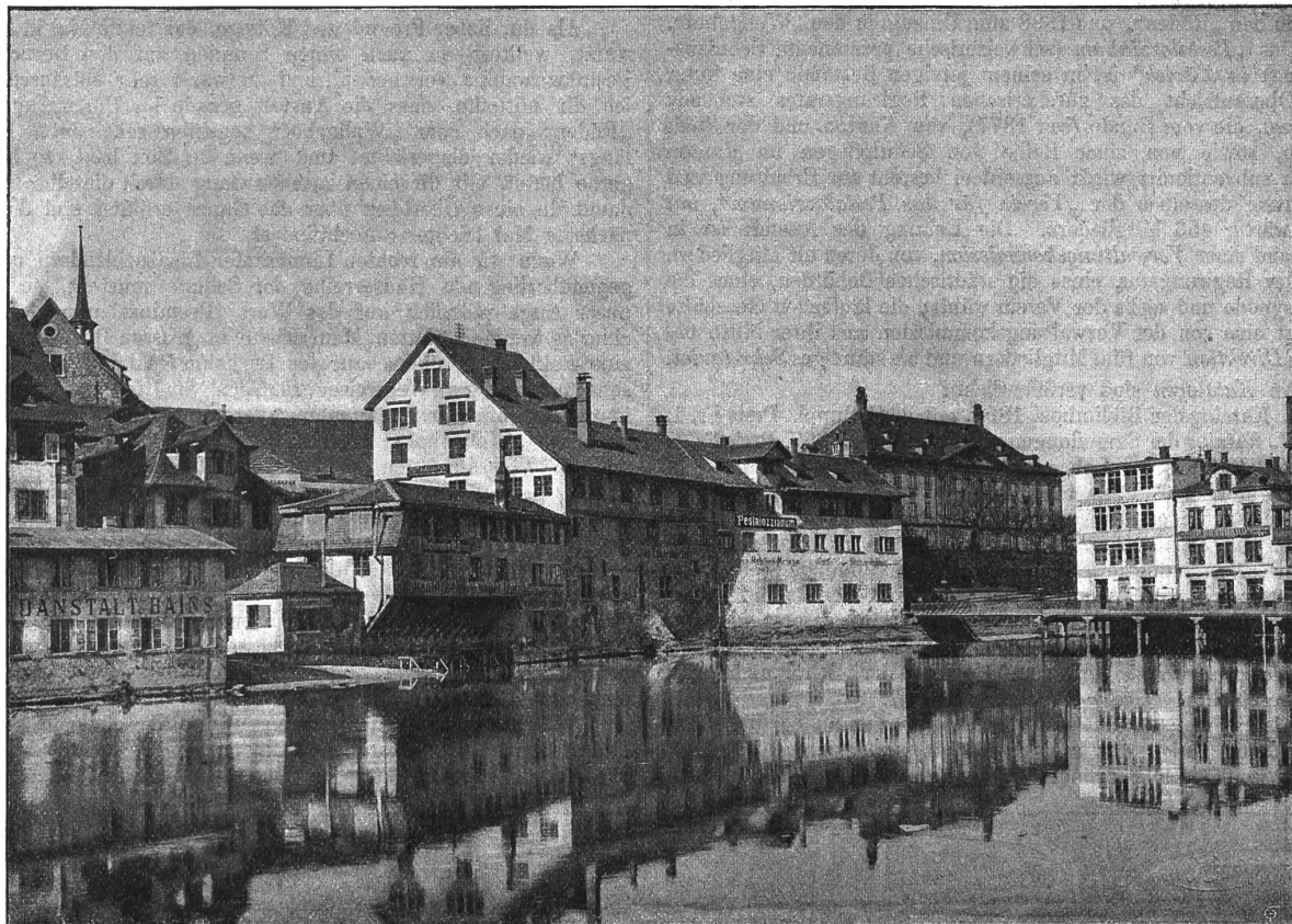
Ansicht des Pestalozzianums.
