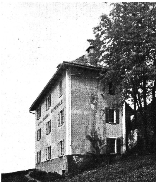
Schulhaus in Sonogno.
