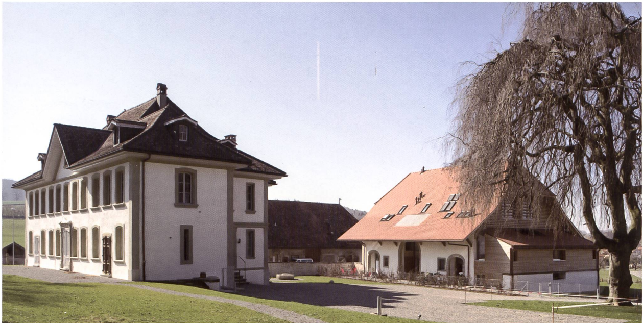
IM HERZEN DES LANDGUTS: DAS HERRENHAUS, DIE GEGENÜBERLIEGENDE SCHEUNE, DAS BAUERNHAUS AUF DER ANDEREN STRASSESEITE UND DIE HÄNGEBUCHE IN DER HOFECKE.
