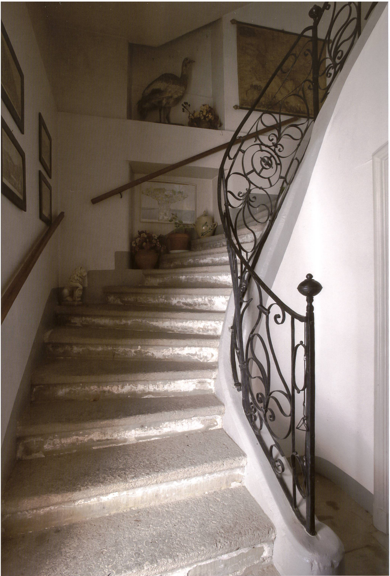
LA CAGE D'ESCALIER CONDUISANT À L'ÉTAGE, AVEC SA BALUSTRADE EN FER FORGÉ TYPIQUE DE L'ÉPOQUE À LA VILLE COMME À LA CAMPAGNE.
