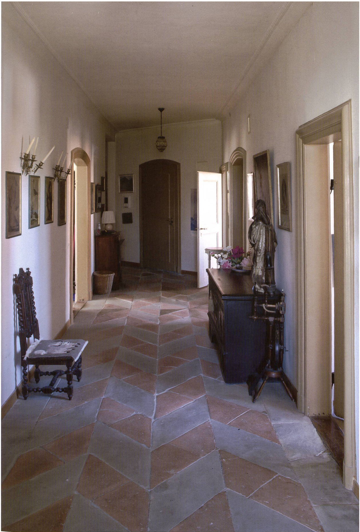
LE CORRIDOR DE L'ÉTAGE, AVEC SON DALLAGE D'ORIGINE EN CHEVRONS ALTERNANT MOLASSE ET TERRE CUITE.
