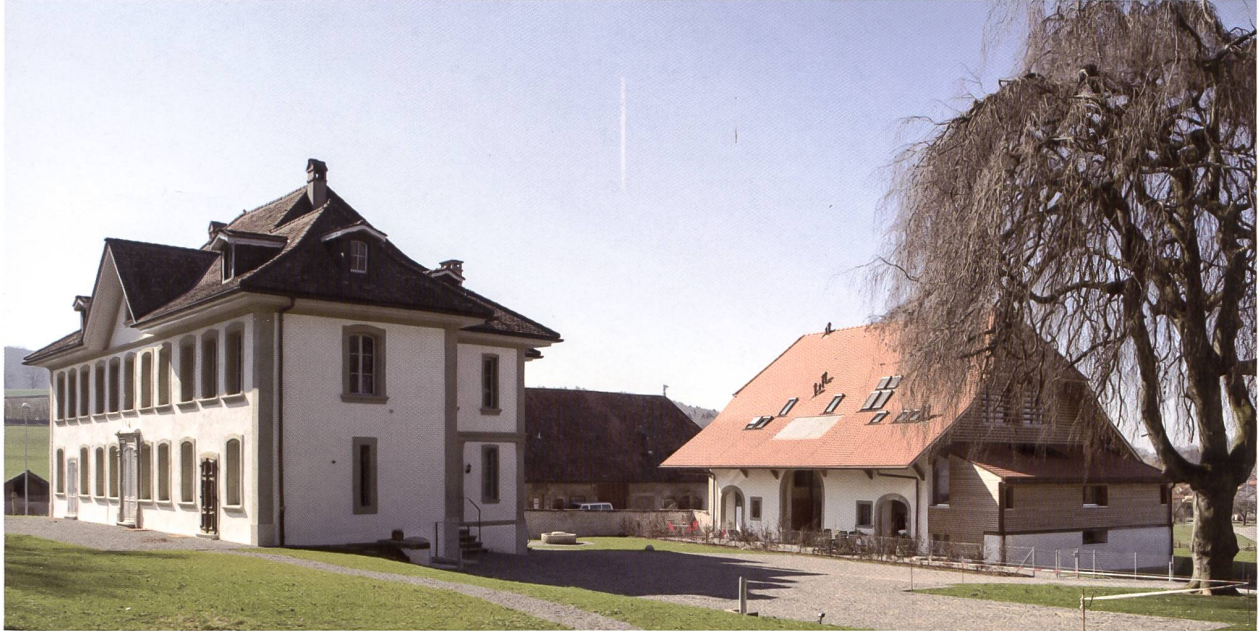
IM HERZEN DES LANDGUTS: DAS HERRENHAUS, DIE GEGENÜBERLIEGENDE SCHEUNE, DAS BAUERNHAUS AUF DER ANDEREN STRASSESEITE UND DIE HÄNGEBUCHE IN DER HOFECKE.
