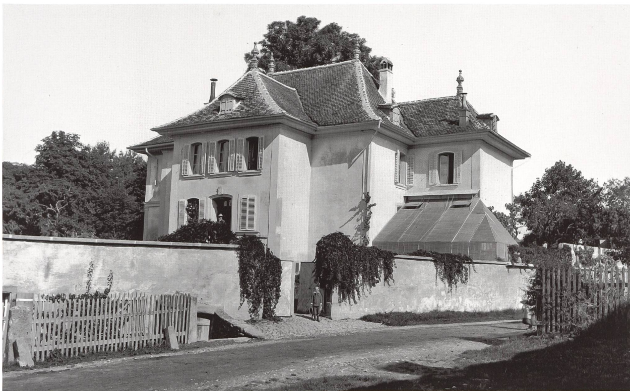
LÉON DE WECK, LE MANOIR VU DU SUD-OUEST, EN 1886, ALORS PROPRIÉTÉ DE JOSEPH-ALOYS DE CHOLLET (1813-1892) QUI Y AVAIT ENTREPRIS D'IMPORTANTES RÉPARATIONS EN 1869, EN PARTICULIER LA SERRE VISIBLE À DROITE, DANS L'ANGLE SUD-OUEST ET LA NOUVELLE ENTRÉE LATÉRALE DANS L'ANGLE OPPOSÉ (BCUF, LWGG 166).
