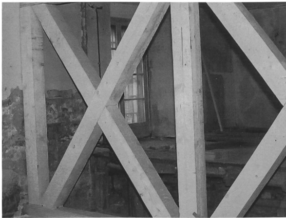
6-7 Un colombage obsolète du point de vue statique a été remplacé par un pan de bois triangulé supportant la structure de l'étage supérieur et déchargeant la poutraison de l'étage inférieur
