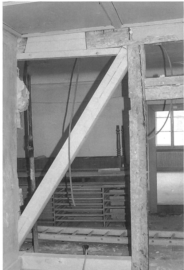
5 Les éléments anciens ont été maintenus en place, la structure réparée, consolidée et stabilisée
