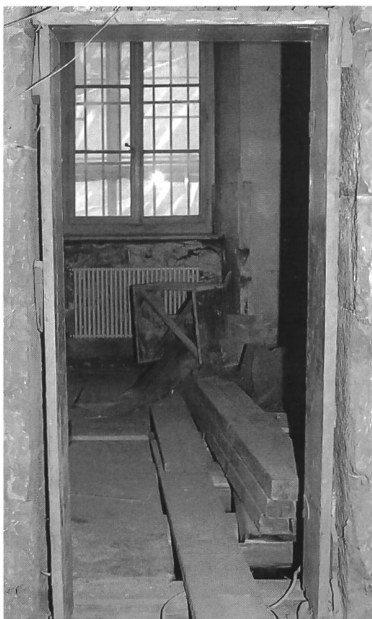
9-10 Les anciens vantaux de portes ont été réutilisés sur des cadres en applique permettant d'adapter les dimensions des percements à celles des portes
