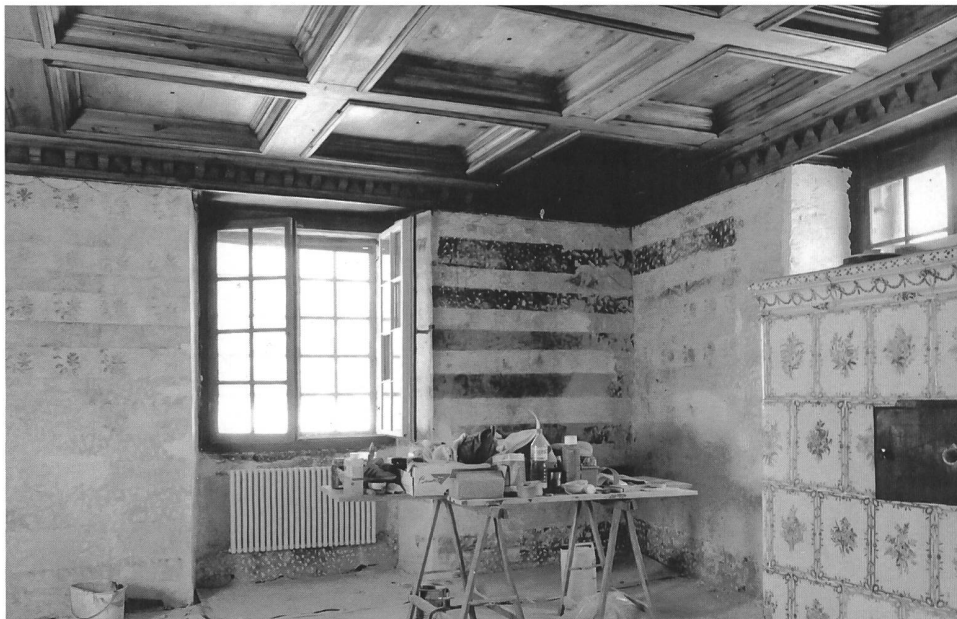
15 La chambre du prieur pendant la restauration
