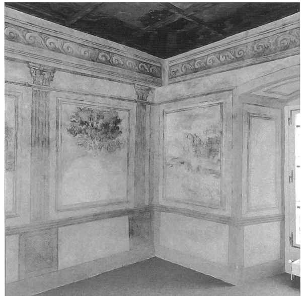
51 Vestibule, décor mural, angle sud-ouest (après restauration)
