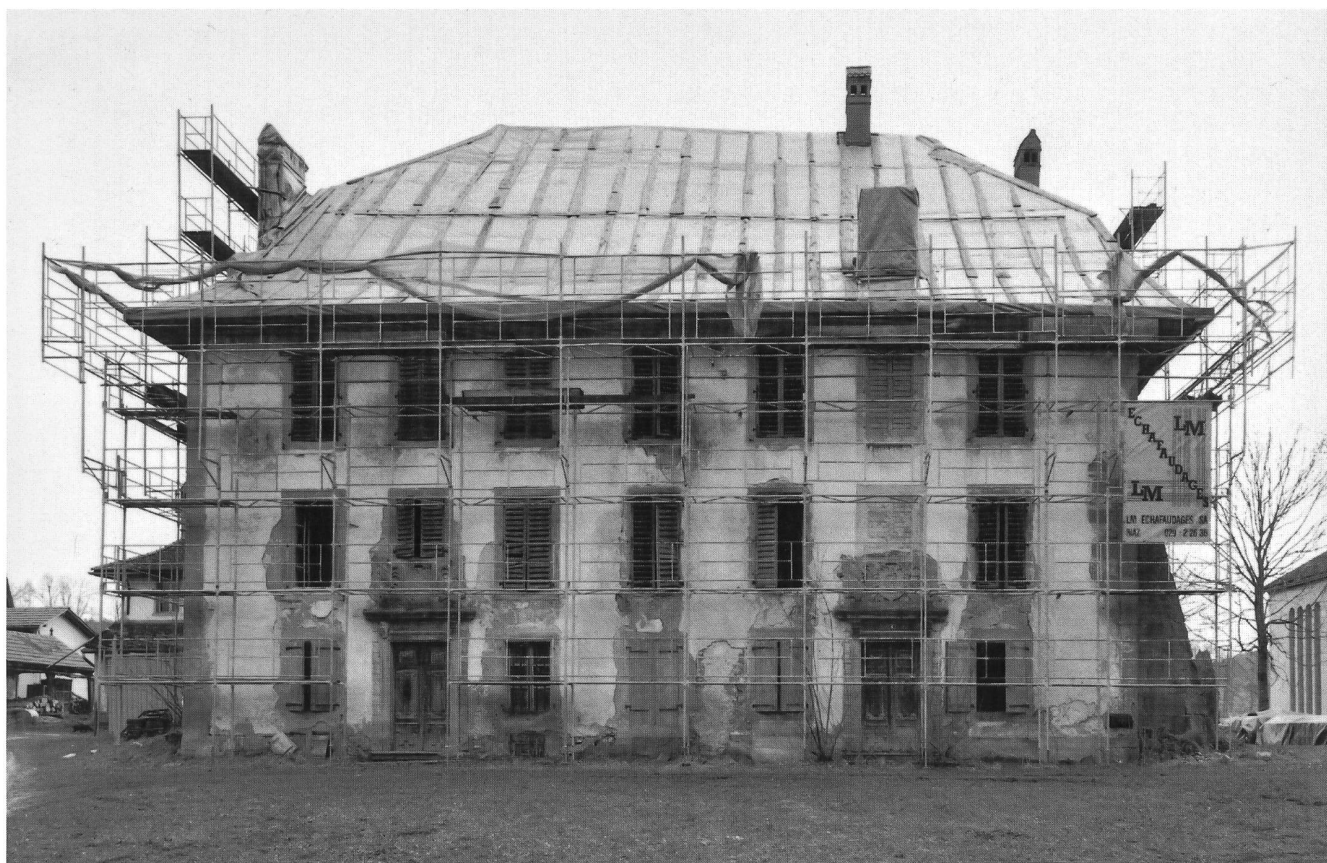
Fig. 12 La façade principale du château en 1994, durant la première étape des travaux.
