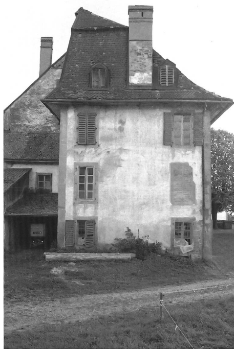
Fig. 25 Façade nord-est avec agrandissement des années 1787-1789.
