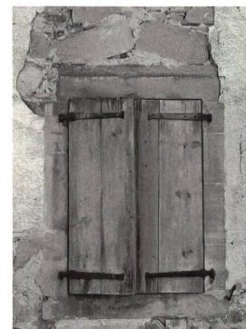
Fig. 28 Façade nord-ouest, porte d'entrée factice, 1787-1789.
