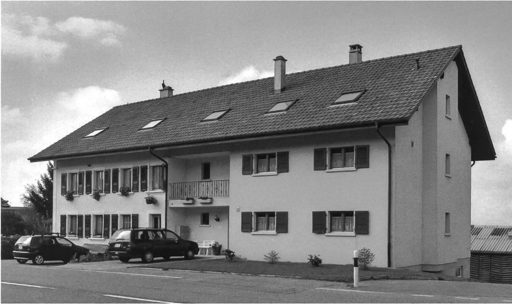
Fig. 3 La façade exprime ici sans équivoque possible le changement d'affectation. Architecture de nulle part et de partout à la fois.
