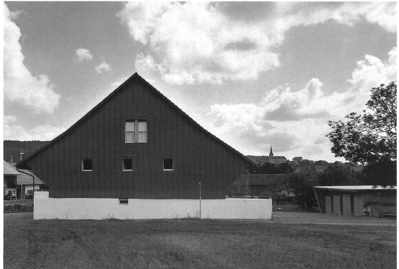
Fig. 10 Façade-pignon de l'ancienne grange après restauration. A l'arrière, la cour est délimitée par l'abri à voiture.
