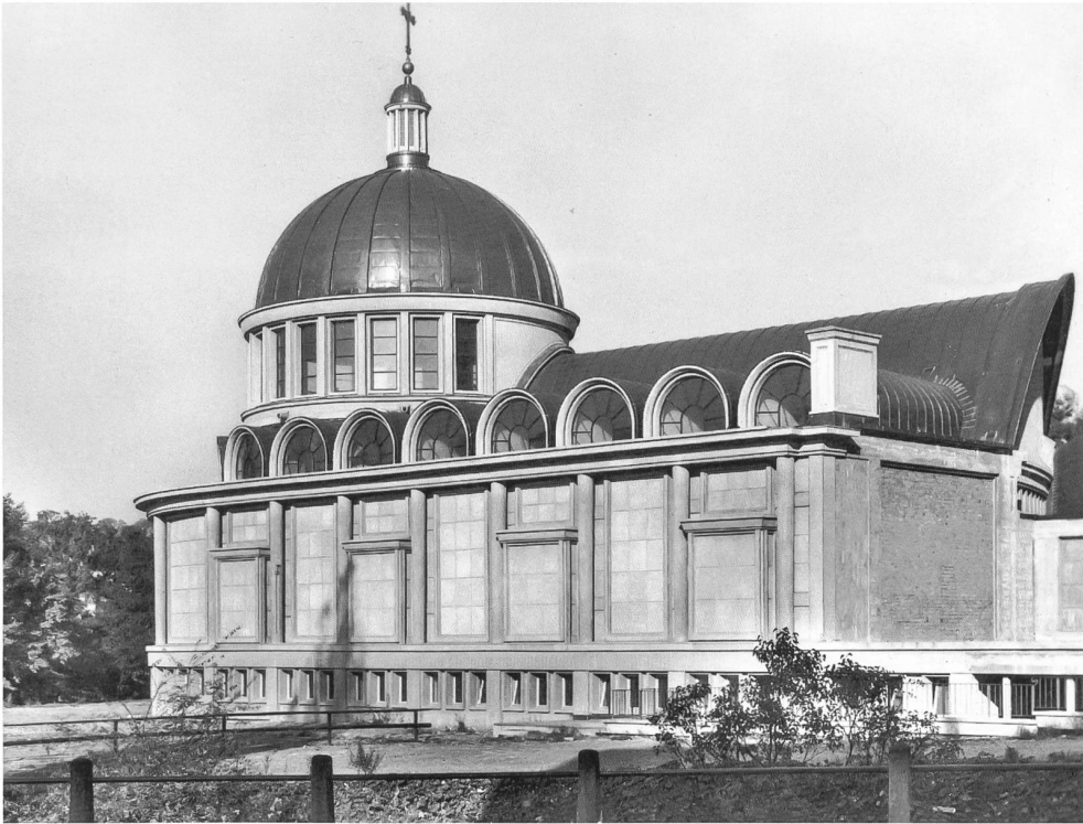
Fig. 30 Vue bucolique de l'église, après l'achèvement de la première étape.
