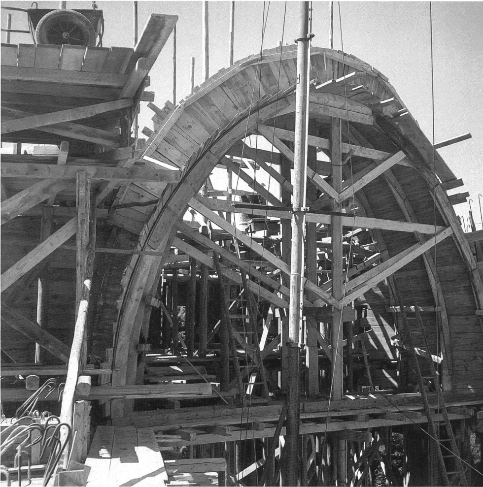
Abb. 51 Die Verschalung des Chorbogens, August 1952.
