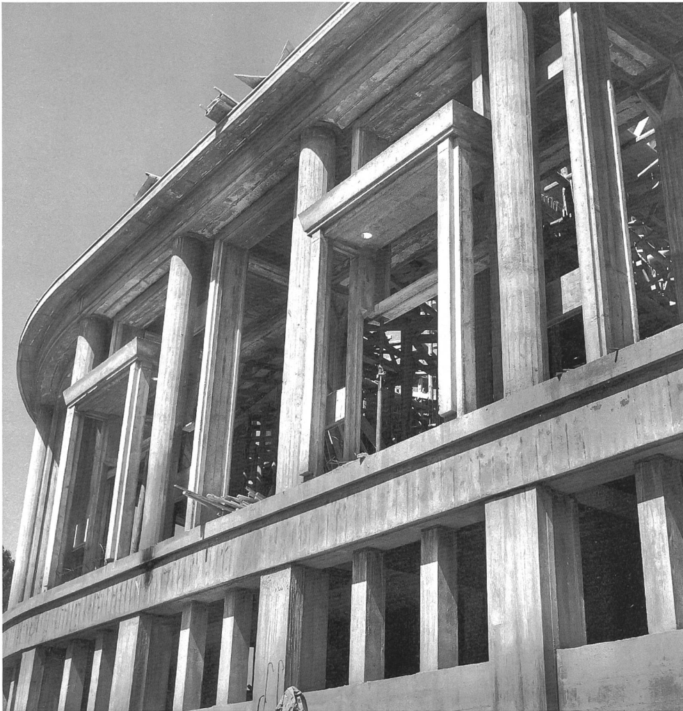
Abb. 47 Das konstruktive Skelett des Chors 1952, welches die «splendide nudité de la construction» (Denis Honegger) zeigt.
