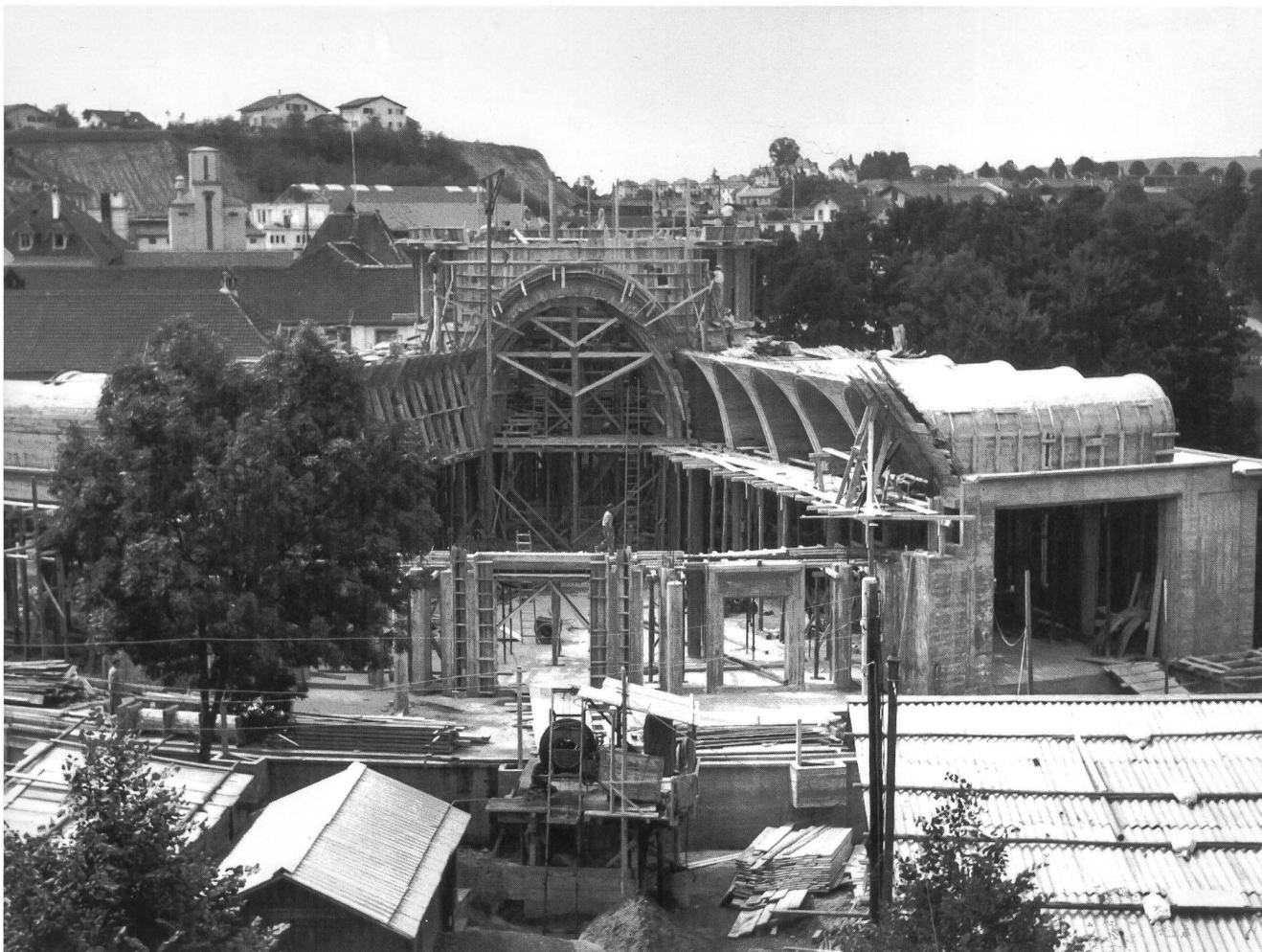
Fig. 53 Das Schiff unmittelbar vor dem Aufsetzen des kegelstumpfförmigen Gewölbes. Im Vordergrund sind die drei Eingänge erkennbar.
