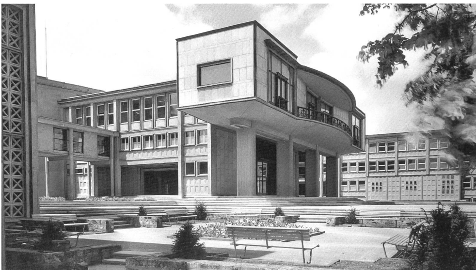
Fig. 77 L'Université de Miséricorde, avec au centre, le pavillon des services généraux. – Il s'agit d'un collage manifeste entre l'architecture de Perret et le projet pour le siège de la Société des Nations, à Genève, de Le Corbusier.
