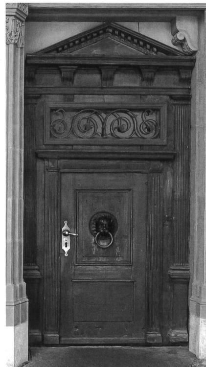
Fig. 104 Porte principale, réalisée en 1583 par Hieronymus Lendyszen, simplifiée et rénovée en 1788-1789 par Joseph Moser. Le panneau supérieur a été remplacé vers 1945 par une grille conçue dans le style du XVII<sup>e</sup> siècle. – La gravure de Martin Martini (fig. 2) montre l'état originel de la porte, avec tous ses éléments maniéristes: arcatures et pilastres géminés, et stylobates à pointes de diamant.
