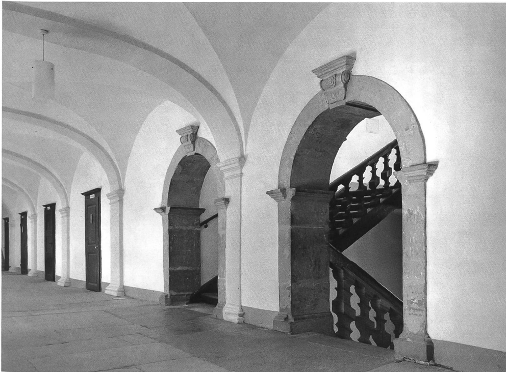
Abb. 58 Osthälfte des zweischiffigen Korridors im ersten Stock des Ostflügels von 1722. Rechts die schlichten Türen der Mönchszellen und die Arkaden der Treppe in der Mittelachse.
