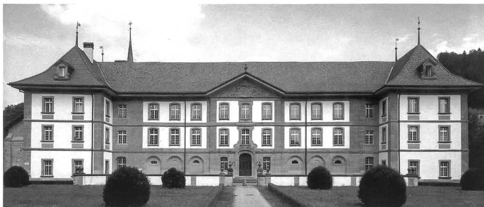
Abb. 48 Konventbauten, Westfassade von 1767 mit Südwestpavillon (rechts) von 1748/49. Hinter dem Mittelrisalit liegt die zweigeschossige Ehrentreppe. Das Fronton zeigt, nebst Putten mit den Abtsignien, das Wappen des Abtes Emmanuel von Lenzburg.
