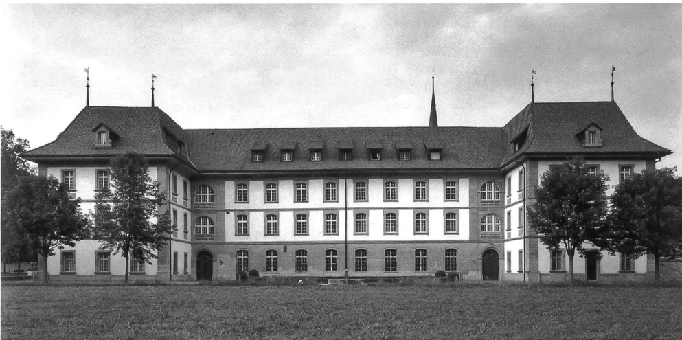
Abb. 53 Konventbauten, Südtrakt von 1748/49 mit dem Südwestpavillon (rechts) des Ostflügels von 1722.
