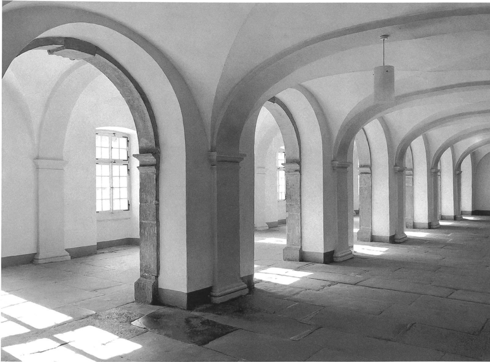
Abb. 56 Zweischiffige, vom Kreuzgang her belichtete Halle vor den Mönchszellen im ersten Stock des Ostflügels von 1722, ein Ergebnis des Doppelkorridors. Die linke Hälfte des gewölbten Raums liegt über dem mittelalterlichen Kreuzgang.
