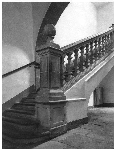
Abb. 57 Beginn der grossen Treppe in der Mittelachse des Ostflügels von 1722.
