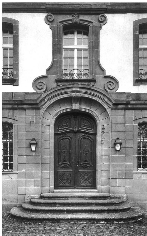
Abb. 55 Konventbauten, Mittelachse der Westfassade von 1767 mit eichener Rokokotüre.
