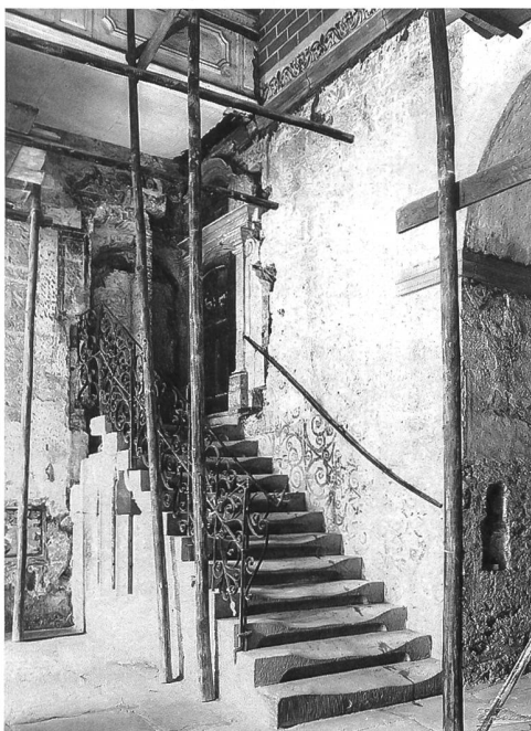
Fig. 70 L'escalier du dortoir en 1906, pendant la restauration. Première marche datée 1665. Grille baroque en fer forgé.
