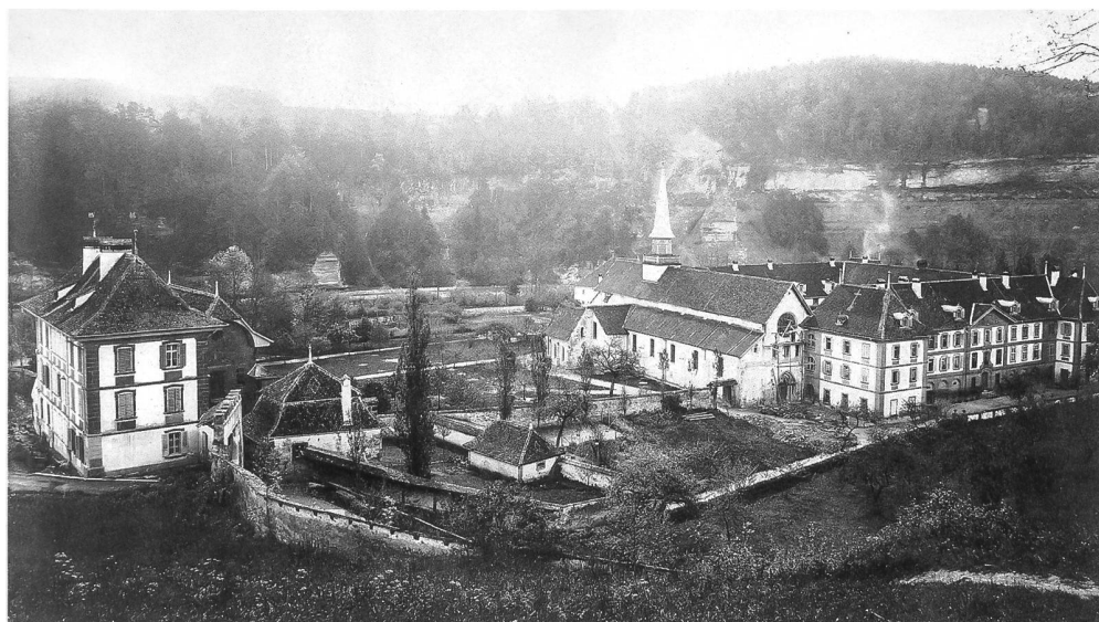
Fig. 65 L'abbaye en 1905, après la reconstruction de la toiture des bâtiments conventuels. Un échafaudage est dressé contre la façade occidentale de l'église, en vue de la reconstitution de la rose. Le clocheton construit après l'incendie ne sera remplacé qu'en 1908.
