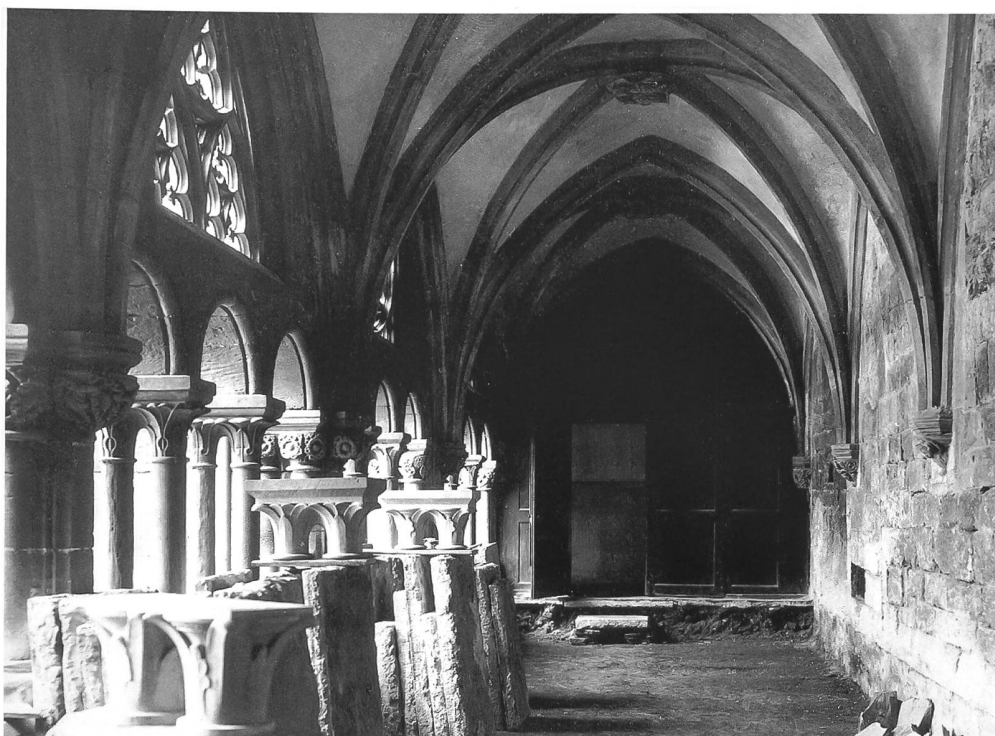
Fig. 73 La galerie occidentale en 1910, en cours de restauration.
