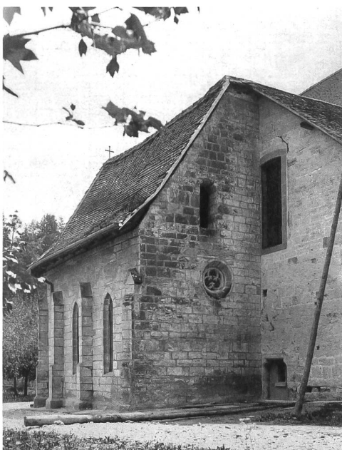
Fig. 66 L'angle du croisillon nord et de la chapelle St-Nicolas, avec la fenêtre baroque de 1747.
